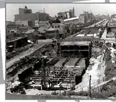
建設中の栄駅
